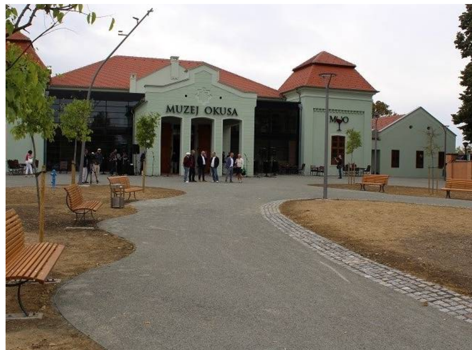
Primjer pristupne staze od stabilizera ispred javne ustanove. Postavljanjem stabilizera na ovakvim površinama smanjuje se potreba za sustavom odvodnje.
