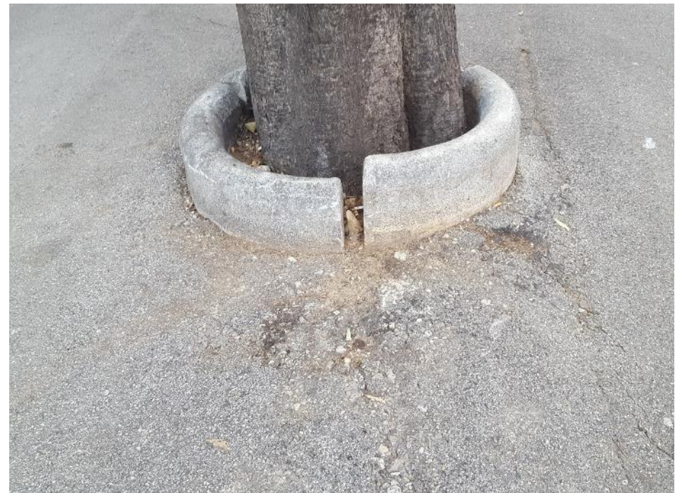
Prikazi oštećenja asfalta i rubnjaka
