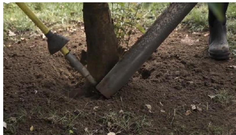
Slika gore desno- Metoda usisavanja tla eng. vacuum excavator
