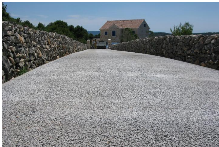
Primjer pristupne staze od poroznog betona .
