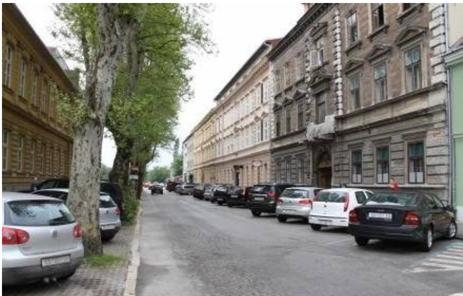
Nazorova ulica u Karlovcu (prije sanacije), zbog asfalta i betonskih opločnika postavljenih direktno uz deblo, korijenje je izdiglo rubnjake, a radi ograničenog prostora za rast platane su se nagnule u stranu.
