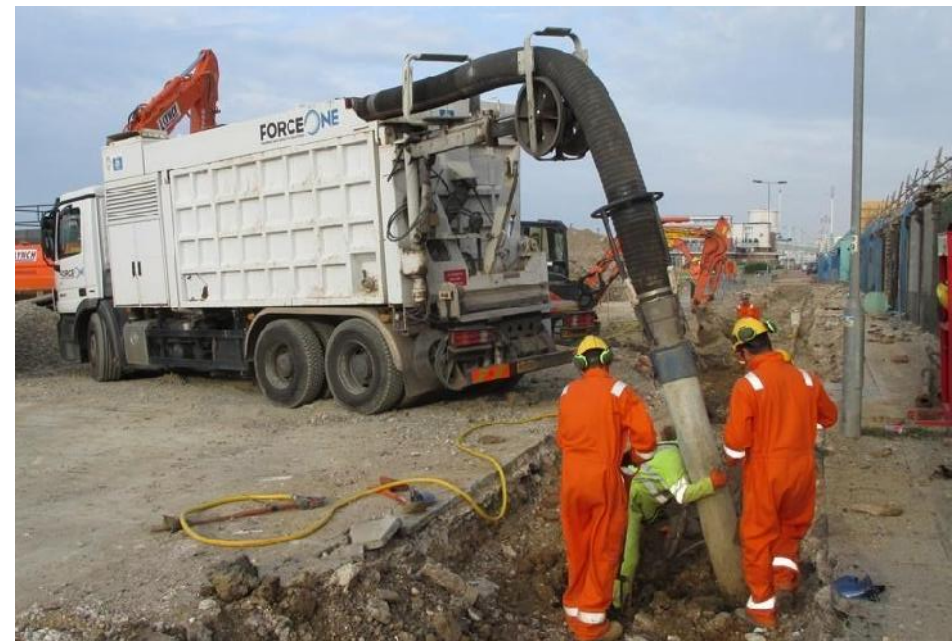
Prikaz izgleda stroja za usisavanje tla (eng. suction excavator ili vacuum excavator).
